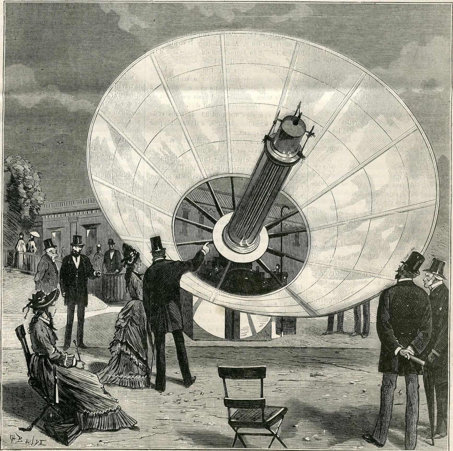
EXPOSITION UNIVERSELLE. — APPAREIL MOUCHOT, POUR L'UTILISATION INDUSTRIELLE DE LA CHALEUR SOLAIRE. EXPÉRIENCE SUR LE TROCADERO. — Voir page 647.
