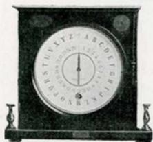
Récepteur à cadran de Breguet
