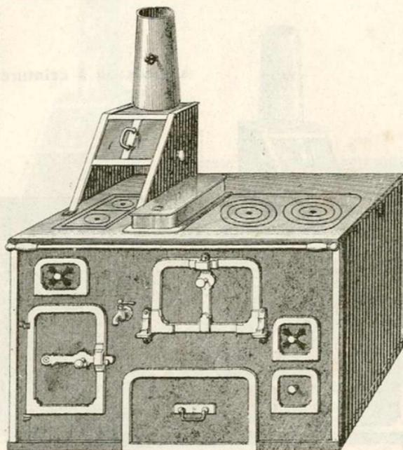
Se composant d'un four à retour de flamme, d'un chauffe-assiettes, d'une chaudière avec robinet, d'une poissonnière formant deux réchauds, d'une grillade double départ et d'un charbonnier monté sur galets.
