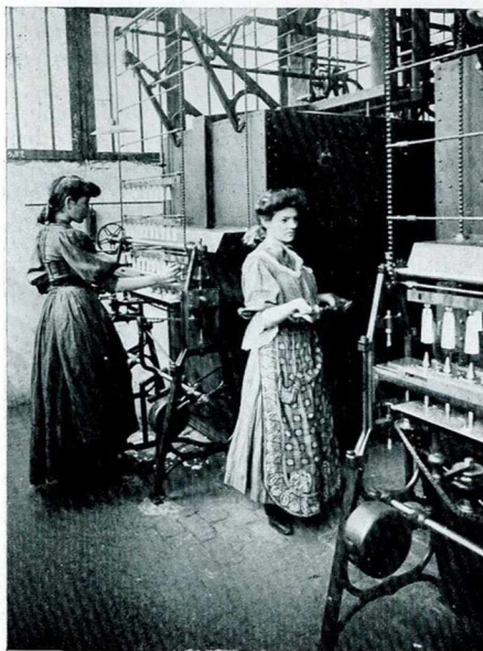
Fig. 7. — Four à sécher et coupage des Manchons.
