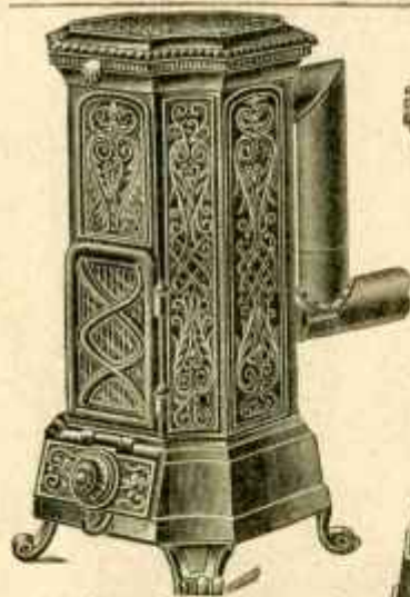
Calorifère Godin fonte ajourée, à feu visible et continu, intérieur briques réfractaires, double tirage.
