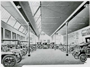
Garage de MM. Magnat et Debon, Grenoble
