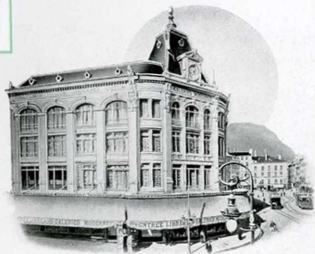
Nouvelles Galeries de Grenoble
