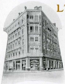
Maison de M. Michon à Grenoble
