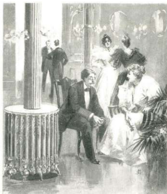
L'emploi des Radiateurs circulaires est tout indiqué pour le chauffage des grandes salles contenant des colonnes.
