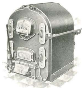
Chaudière "Idéal" pour Eau Chaude, Type "Cyclone".
