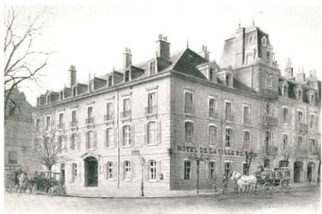
Hôtel de la Ville de Lyon, à Dole chauffé par des Appareils "Idéal".
