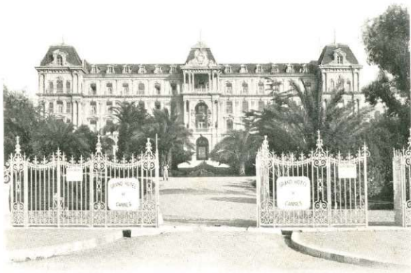
Grand Hôtel, Cannes, chauffé par des Appareils "Idéal".
