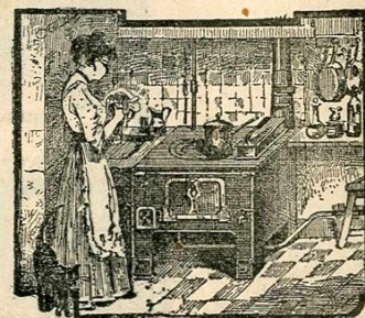
Foyer-Cuisinière en tôle.
