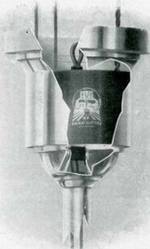
A. — Télerrupteur placé au plafond, intercalé entre le pignon et le tube du lustre (représenté caché en partie par une garniture quelconque).
