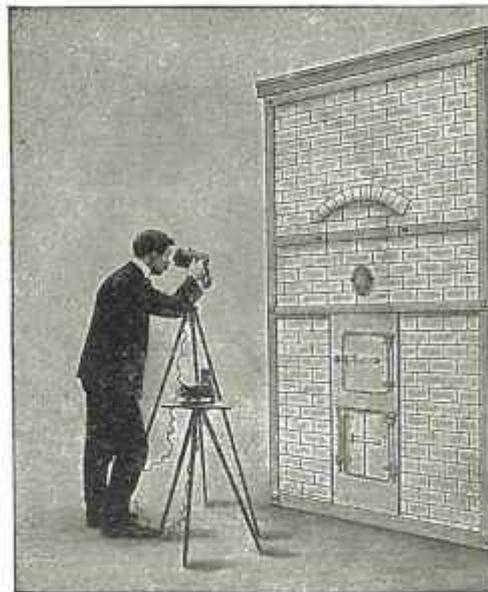
Fig. 6. — Emploi du télescope pyrométrique.
