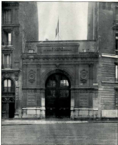
Chauffage à air chaud. Grande Cuisine. — Plonge et divers. Exécutés en 1881, sous la direction de M. LISCH, architecte D. P. L. G. (Entretenu par la Maison depuis cette époque.)
