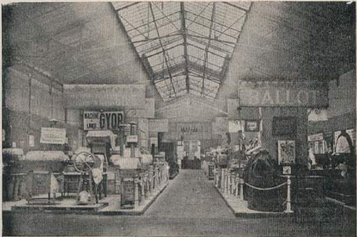
Fig. 1. — Un des halls du Salon des Appareils Ménagers.
