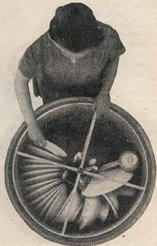
Fig. 30. — Le panier tournant présente successivement ses différents secteurs sous la main même de l'opérateur.
