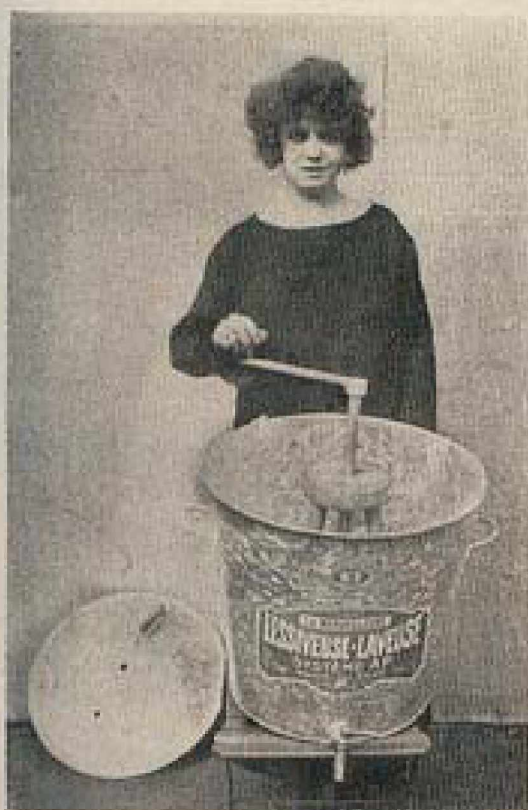
Fig. 16. — Lessiveuse « La Merveilleuse » couvercle enlevé.
