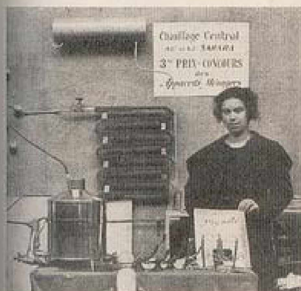
Fig. 72. — Chaudière Mourret et canalisation au stand du Salon Ménager.
