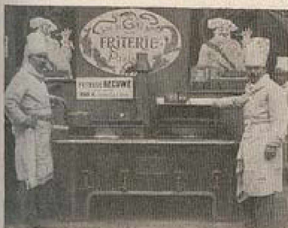
Fig. 55. — Vue de la friterie Becuwe installée au Salon Ménager.
