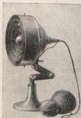
Fig. 79. — Radiateur Garba type médical à gaz.
