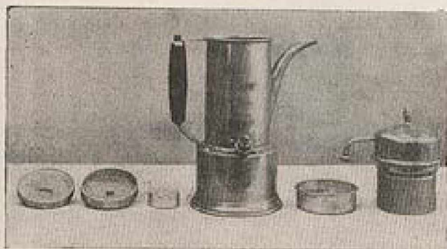
Fig. 186. — Cafetière Pouget démontée.
