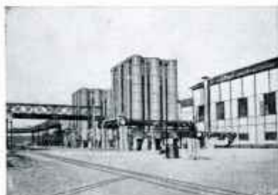
INSTALLATION DE CONDENSEURS A AIR
