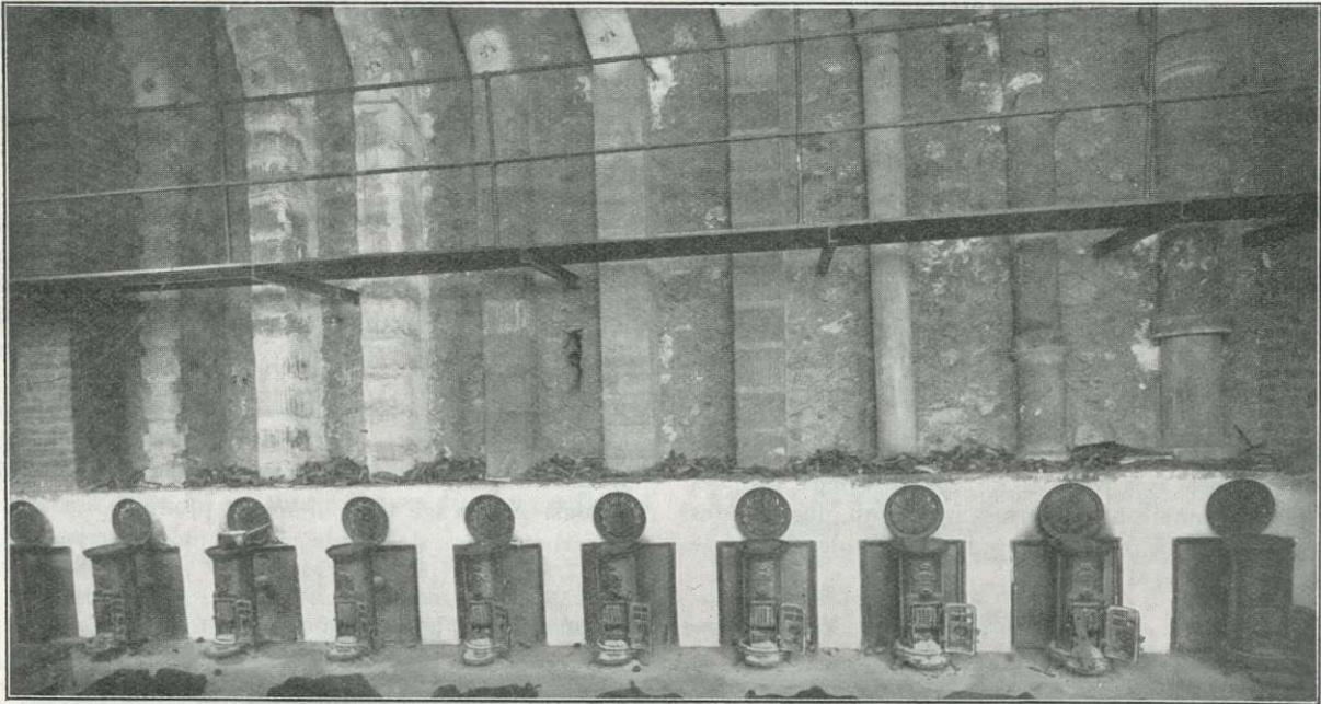
Fig. 2. — Essais avec des poêles à feu lent.
