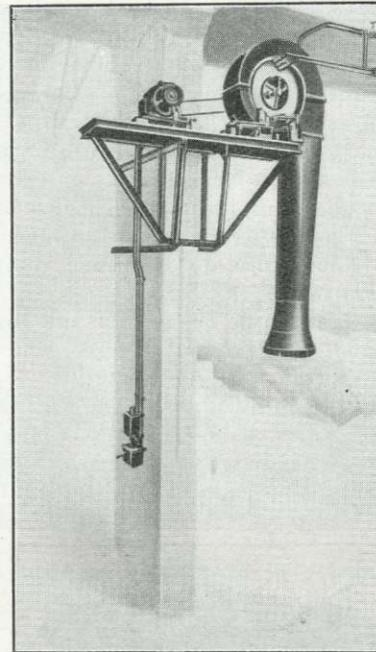
Fig. 4. — Échangeur muni d'un diffuseur circulaire.
