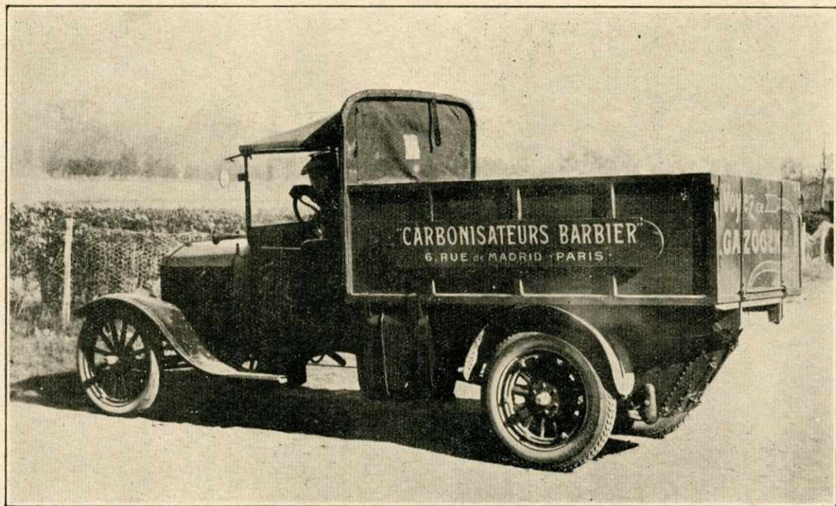
Fig. 16. — Camionnette Ford. — Gazogène Barbier
