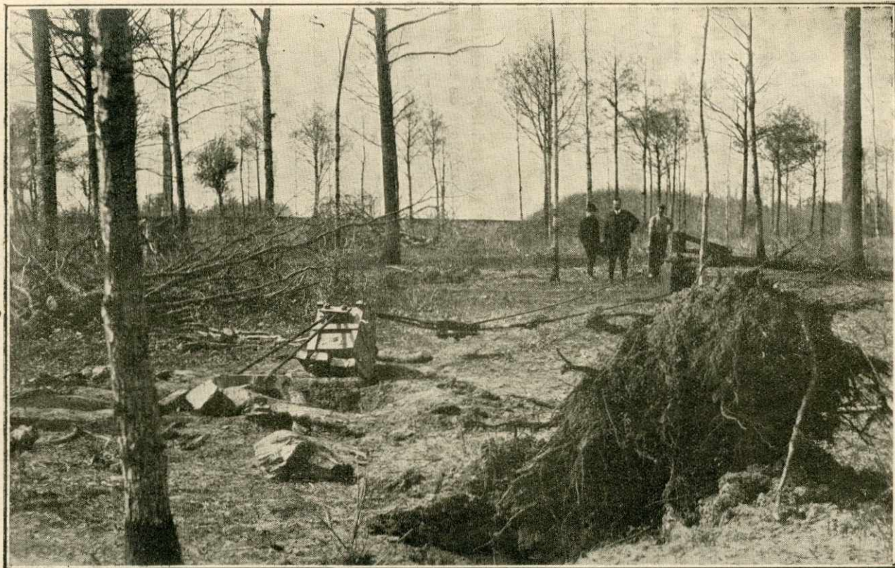
Fig. 2. — Treuil Pan. — Démonstration de dessouchage.
