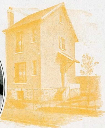
Pavillon à Villeneuve-le-Roi, chauffé par Fourneau "IDEAL CULINA" et 3 Radiateurs.
