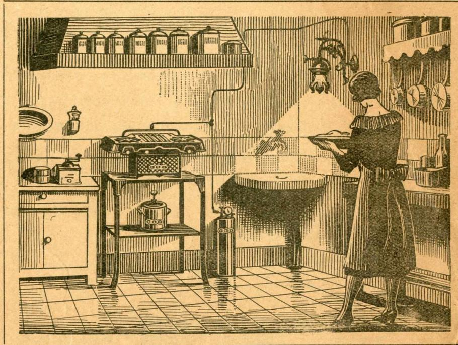
Type d'une installation conjuguée d'éclairage et de chauffage à gaz d'essence, par réservoir séparé
