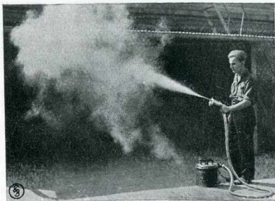
Distribuidor de polvos acoplado al aspirador de polvo «Protos», sirviendo de destructor de insectos
