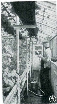
Distribuidor de líquido acoplado al aspirador de polvo «Protos», sirviendo de rociador de flores
