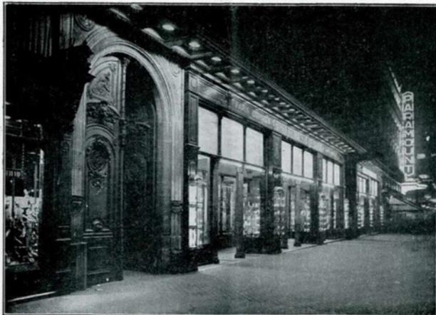
Fig. 1. — ECLAIRAGE DE LA FAÇADE D'UN GRAND MAGASIN PAR REFLECTEURS EN VERRE ARGENTÉ ESPACES DE 0 m. 80. LAMPES DE 150 WATTS.
