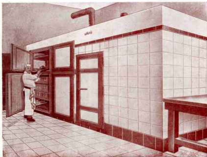
Fig. 9. Chambre froide installée avec une machine "BOREAS" de 2.500 frigories pour le compte d'un grand hôtel
