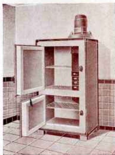
Fig. 6. Armoire "BOREAS" type A 1 de 150 frigories. Volume utile de 0,150 m 3
