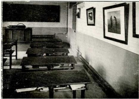
Une salle de classe : le long des murs, les éléments chauffants horizontaux et d'une grande surface.
