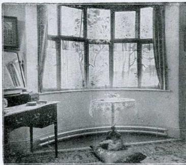
Boudoir chauffé au procédé électrique « Mecano » à basse température
