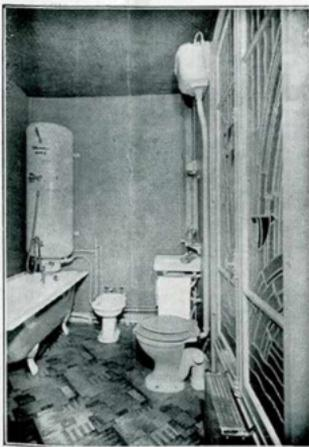
Fig. 8. — La salle de bains équipée avec un chauffe-eau à accumulation de 100 litres, alimentant la baignoire, l'appareil à douche et les autres postes. Au-dessus de la glace du lavabo, on remarquera une applique en porcelaine diffusante avec douille étanche.
