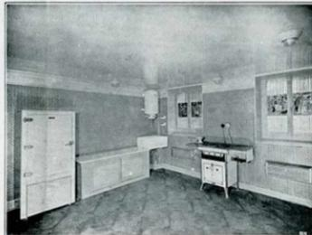
Fig. 7. — La cuisine comprenant uniquement des appareils électriques : une armoire frigorifique, un chauffe-eau à accumulation de 20 litres et une cuisinière à laquelle sont adjoints un grill et une plaque de petit diamètre.
