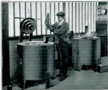
Fig. 1. — Une batterie de deux fours de fusion de 50 kW chacun.
