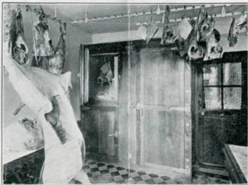
FIG. 1. — Armoire frigorifique électrique installée chez un boucher, à Varreddes. L'évaporateur est situé dans le compartiment du milieu et la machinerie est placée en dehors de l'armoire, dans un débarras contigu au magasin.
