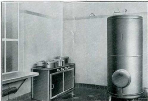
FIG. 8. -- Meuble de Service et chauffe-eau de 500 litres.
