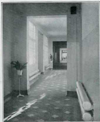
Fig. 3. — Chauffage d'un couloir par radiateurs.
