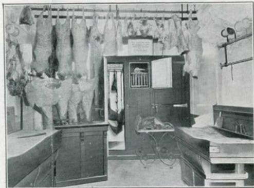
FIG. 3. — Appareil commercial installé chez M. Robois, boucher, à Meaux. On remarque au centre l'évaporateur légèrement givré. La machinerie est placée derrière l'armoire.
