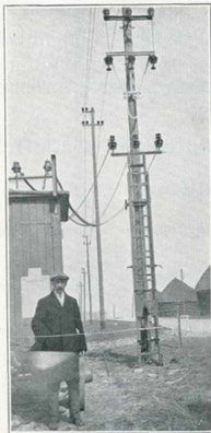
Fig. 2. — Echelle de prise de courant, type G.O.L., 15 000 volts, cabine de 20 KVA pour battage en platine.
