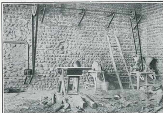
Fig. 1. — Moteur de 2 ch actionnant une transmission. Ferme de M. Jalliet à Blyes (Ain)
