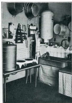
Fig. 6. — Réunion d'un appareil auto-cuiseur (Electro-économe) et d'un réchaud à une plaque. (extrait du film « Prospérité »)
