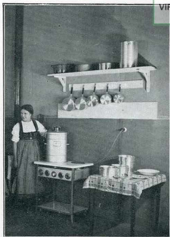
Fig. 7. — Installation de cuisine à Ebersheim (Bas-Rhin). De gauche à droite, l'Electro-économe, un réchaud 2 plaques 22 cm, Salvis 3 000 W, un chauffe-eau à accumulation de 50 litres.
