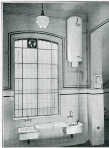
Fig. 5. — Le chauffe-eau à accumulation alimentant l'office.
