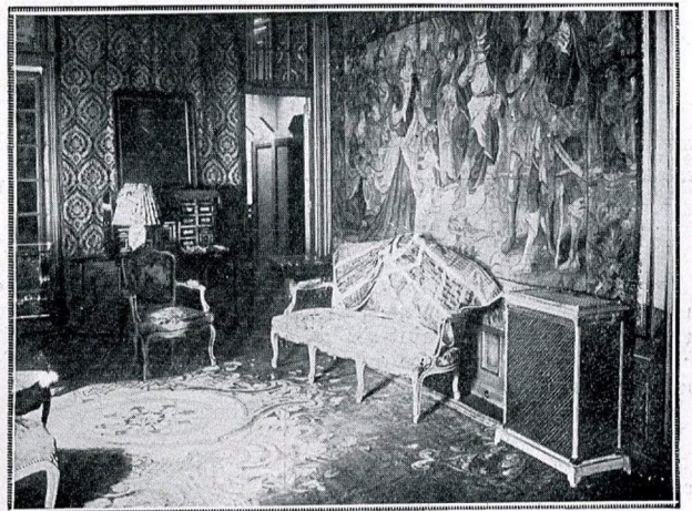
A droite, un appareil à accumulation établi au-dessous de tapisseries de valeur, sans inconvénient pour celles-ci.
