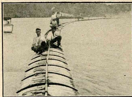
FIG. 6. — Le tuyau flotte à la surface du Rio Canimar, et les ouvriers achèvent son équipement. On remarquera le câble destiné à répartir les efforts de traction.
