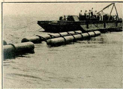
FIG. 4. — Construction d'une estacade protectrice longue de 500 mètres, en doubles flotteurs d'acier.
