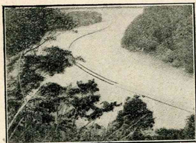
FIG. 7. — Vue prise, du haut d'une falaise, du tube serpentant sur le Rio Canimar.
