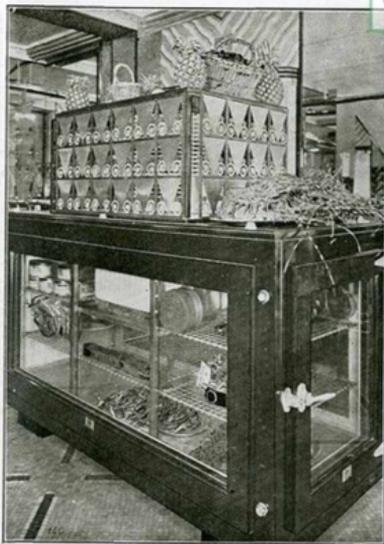
Fig. 7. — Restaurant Jossot. — L'armoire froide « de présentation ». Les parois sont transparentes. Le compresseur, à la partie supérieure est caché par un motif moderne en fer forgé ajouré pour permettre la circulation d'air qui refroidit le serpentin.
