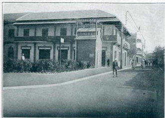
Fig. 2. — Poste de transformation urbain du réseau de Dakar.
