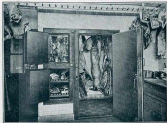
Fig. 2. — Vue de l'intérieur de la chambre froide.
