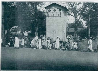
Fig. 3. — Poste de transformation installé à Thiès.
