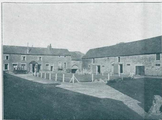
Fig. 1. — Vue de la maison d'habitation et d'un corps de bâtiment où sont installées les applications de l'électricité.
