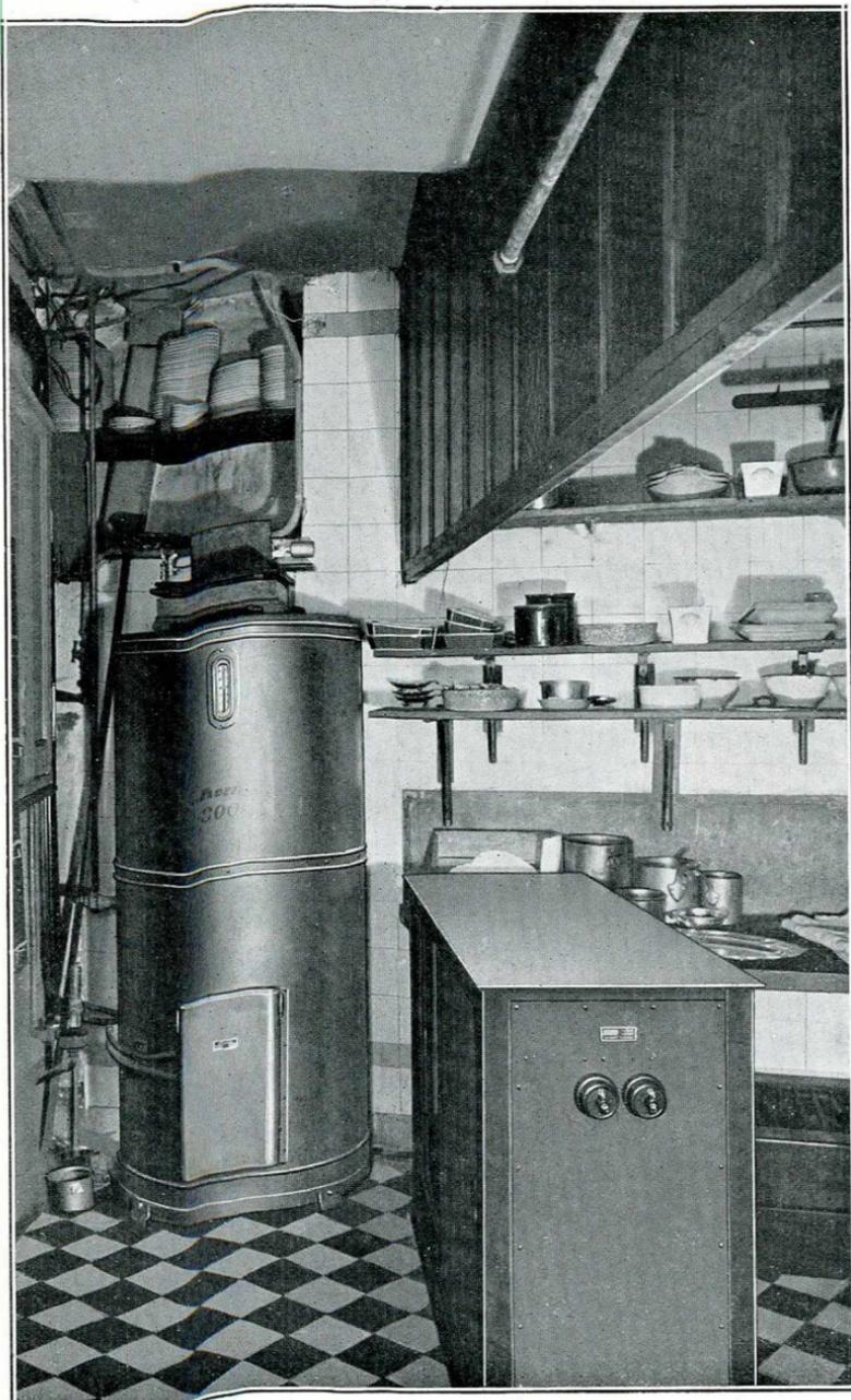
Fig. 5. — *Chauffe-eau à proximité d'une table chaude.*
