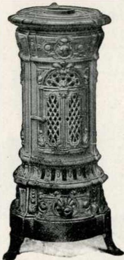
Les calorifères N<sup>os</sup> 10, 11, 12 et 13 ont un foyer en fonte brûlant la houille et le coke.
