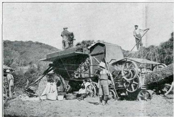
Fig. 2. — Autre vue de la même batteuse; on distingue plus nettement la presse à botteier. Les bottes de paille sont poussées automatiquement sur un éleveur jusqu'à la charrette où un seul homme fait le chargement.
