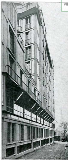
Fig. 1. — Immeuble 51, rue Raynaudard à Paris, façade sur la rue Berton.
