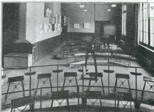
Fig. 3. — Salle de dessin chauffée par des poêles à accumulation, des tubes semi-accumulants et des tubes à chauffage direct servant de chauffeuses.
