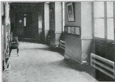
Fig. 1. — Le vestibule du Lycée chauffé par des tubes semi-accumulants.
