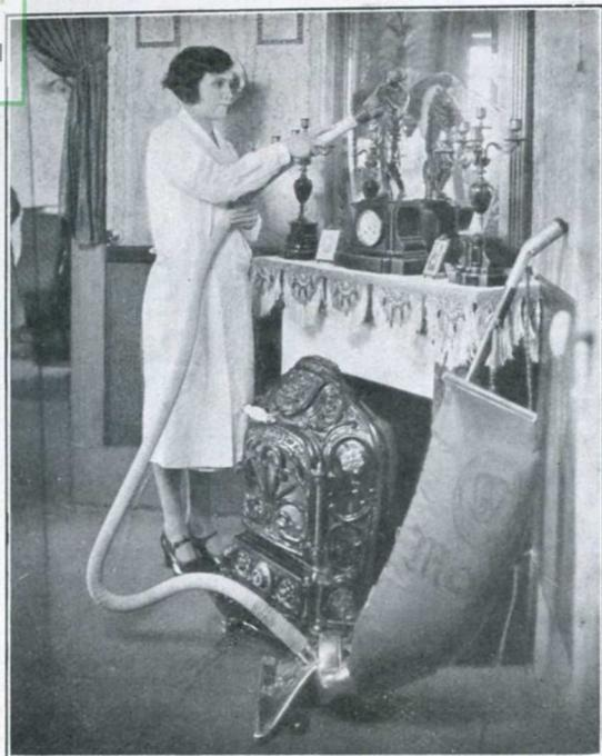
Fig. 2. — Appareil à sac, muni de son raccord souple et d'une ventouse spéciale pour le nettoyage des objets striés.
