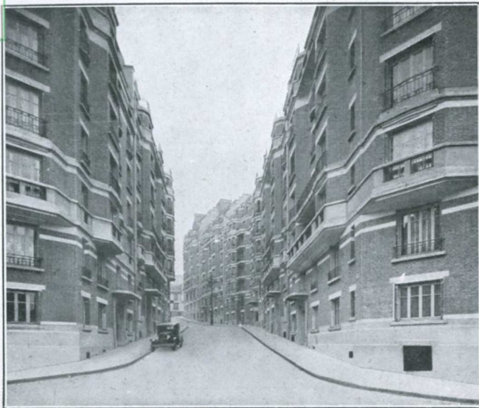
Fig. 4. — Vue générale du groupe d'immeubles de la Compagnie « La Paix ».
