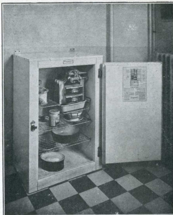
Fig. 1. — Armoire frigorifique alimentée par une installation de froid central. Cette armoire comporte seulement un évaporateur visible en haut et à droite.
