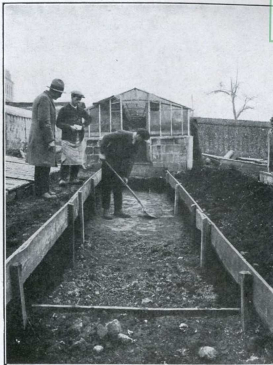
Fig. 3. — On étale sur le mâchefer une première couche de sable fin.
