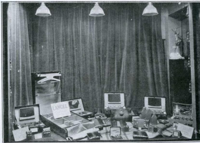
Fig. 3. — Bon éclairage par réflecteurs en verre argenté, dissimulés derrière le fronton. On distingue 3 réflecteurs symétriques en verre prismatique servant pour une autre démonstration.
