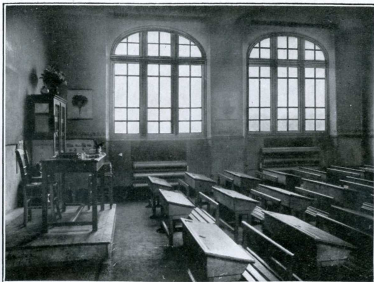
Fig. 7. — Salle de classe du rez-de-chaussée chauffée par des radiateurs tubulaires placés sous les fenêtres.
