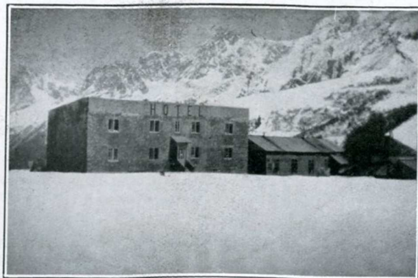
Fig. 2. — L'hôtel du col de Voza, entièrement électrifié.
