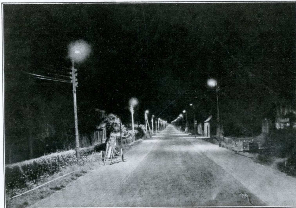
Fig. 1. — Tronçon de la route de Nimègue à Maestricht éclairé par des lampes à vapeur de sodium.
