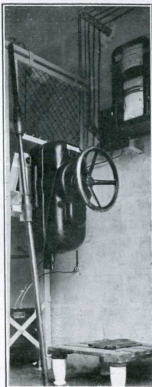
Fig. 3. — Le disjoncteur à commande électrique.
