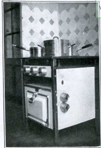
Fig. 5 à droite. Cuisinière à 3 plaques et 1 four installée dans la Villa représentée figure 1.
