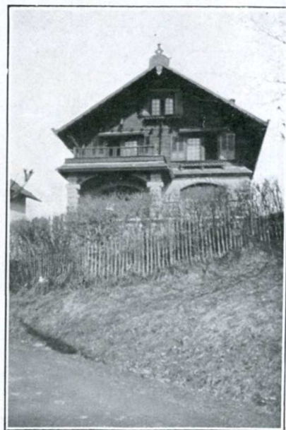
Fig. 3. — Type de villa de location, entièrement électrifiée.
