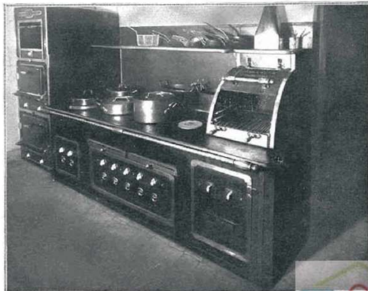
Le grill double du Café de la Paix. A droite le four à trois chambres, le fourneau et le grill électriques du restaurant Rumpelmeyer. — M. Chaffard, architecte.
