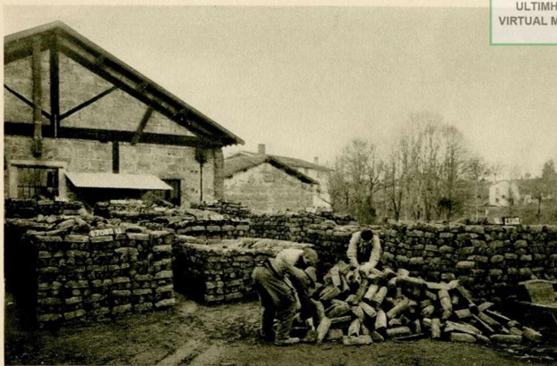
Une partie du stock de fonte en gueuse qui va être travaillée dans le cubilot
