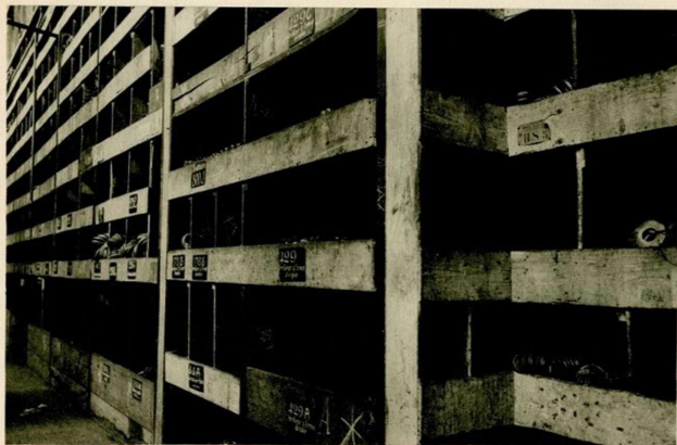
Une des galeries de casiers pour les brûleurs
