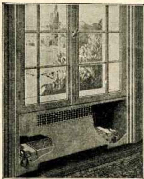
FIG. 57. — Convecteur Circalor installé dans une niche ménagée sous une fenêtre lors de la construction du bâtiment.
