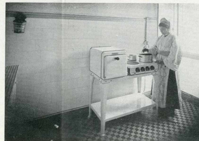
Fig. 5. — Cuisine électrisée de M. F., à Casablanca.
