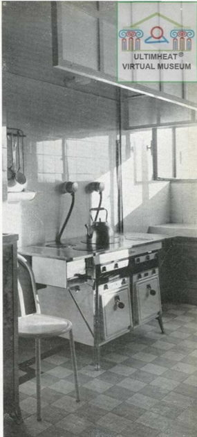
Fig. 5. — Une cuisine dans un immeuble construit par MM. A. et G. Perret, Architectes. Cette cuisine est équipée avec une cuisinière électrique à 5 plaques, deux fours, un chauffe-assiette et un grill.
