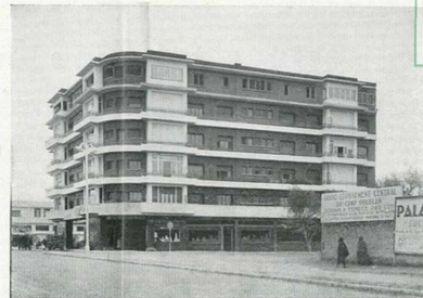
Fig. 4. — Immeuble S. I. F. I. C. H. E., à Meknès, où sont installées 27 cuisinières électriques.
