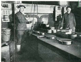
Fig. 3 Fours triples de recuit, de 12 kW chacun.
