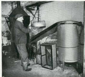
Fig. 6 Bain de dégraissage chauffé électriquement.
