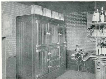
Fig. 5. — L'armoire frigorifique électrique placée dans l'office.
