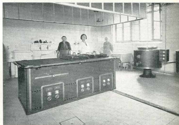
Fig. 5. — Ecole de la Mairie, à Gentilly. Fourneau (plaques et friturier) et marmites.
