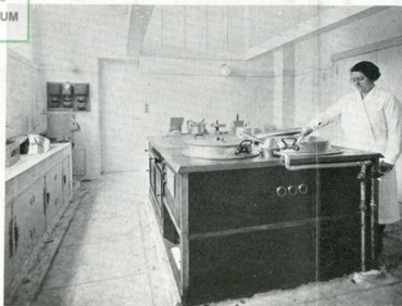
Fig. 7. — Ecole maternelle du nouveau Groupe Scolaire d'Alfortville. Le fourneau comprend deux plaques de cuisson, deux marmites, deux fours à rôtir et une étuve chauffe-plats.
