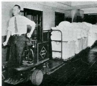
Fig. 2. — Un train de paniers à linge, tiré par un tracteur à accumulateurs.
