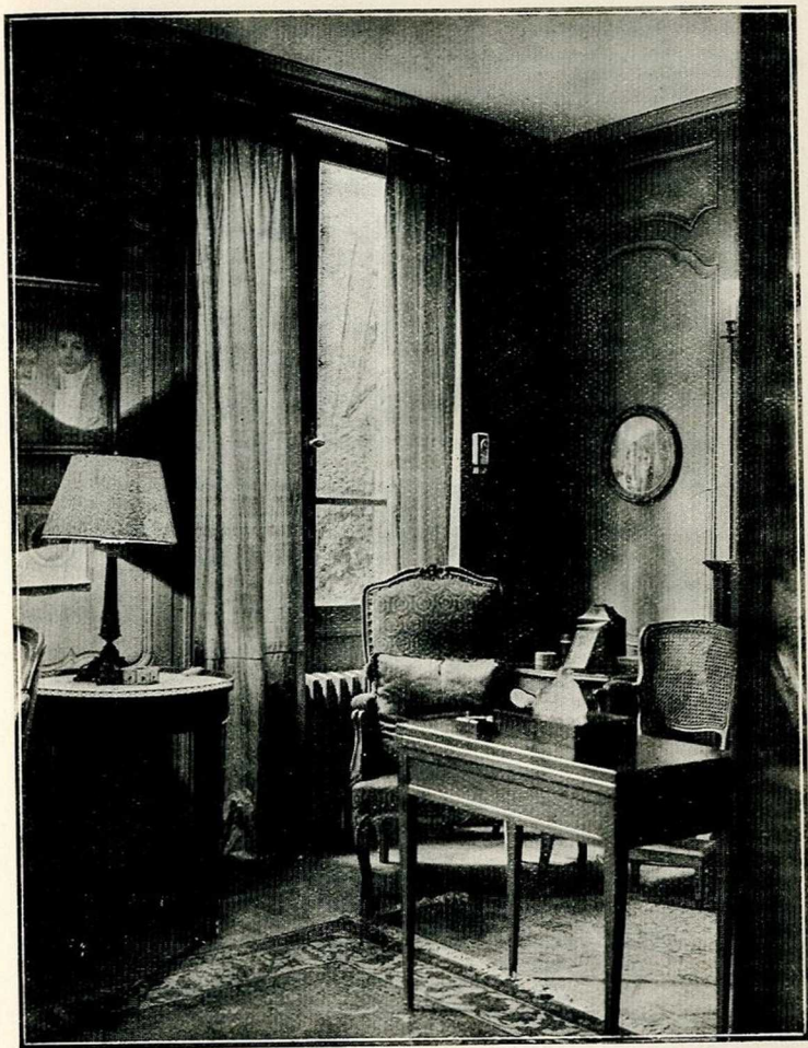
FIG. I. — Un cabinet de travail dans un appartement moderne muni de la régulation automatique du chauffage central par le gaz. — Le petit thermostat qu'on aperçoit près de la fenêtre, à droite, permet à l'occupant de cette pièce d'y avoir constamment, et sans s'occuper de rien, la température qui lui convient exactement. — (voir fig. 10 et 11).
