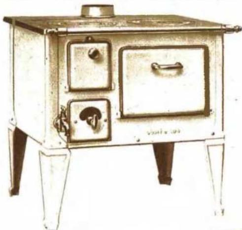
Cuisinière en fonte, avec chaudière, porte de four à ressort, foyer à houille ou foyer mixte.
