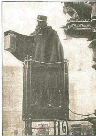
L'Agent du kiosque-vigie de la place de l'Opéra montre son appareil de chauffage Therm'x.
